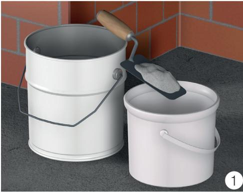
Die erforderliche Menge an natürlichem Quarzsand (0,4 bis 0,8 mm) in einen sauberen Eimer geben, SEALPUR SILAN TX (Harz/ Sand-Mischung im Verhältnis von ca. 1:12) hinzufügen und mit einem elektrischen Rührgerät umrühren.
